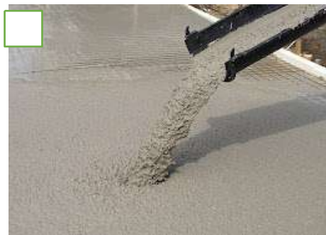
Producția de beton
